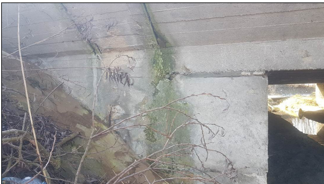
Obr. č. 8 – pohled na objekt zleva - stopy zatékání podél dilatačních spár
