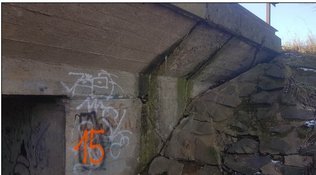
Obr. č. 7 – pohled na objekt zprava - stopy zatékání podél dilatačních spár
